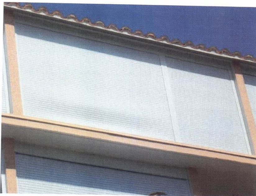
Figure 2 – Bombement du tablier d'un volet roulant
